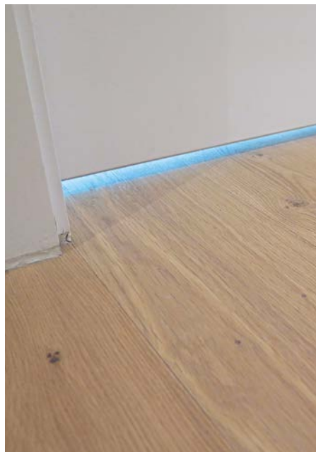
Schlitz zwischen Boden und geschlossener Türe.
