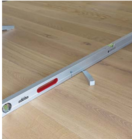
Bodenebenheiten im Toleranzbereich.
