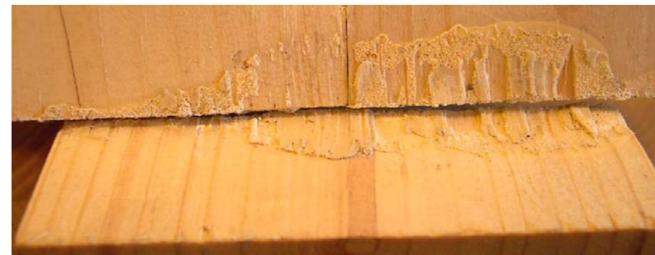
/ Seitliche Verklebung von Holzpfasterklötzen als Folge von Verschiebungen der Elemente im Klebstoff.
