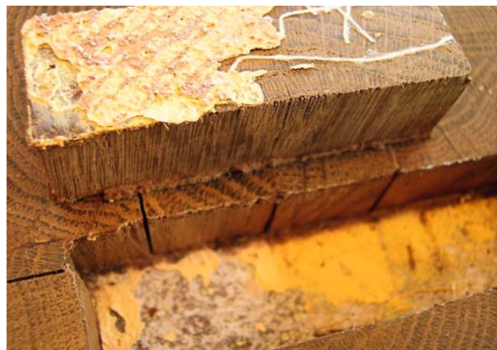
/ Ablösungen von Hirnholzparkett wegen ungenügender Haftung des Holzes über alten Klebstoffrückständen.
